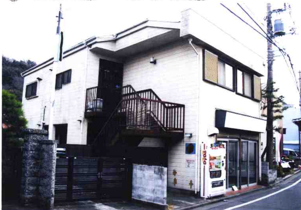
① 受命物件の外観 建物 北 側の状況
